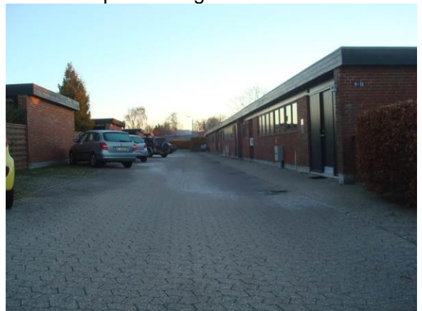
Foto nr. 16 – køreareal med SF belægning
