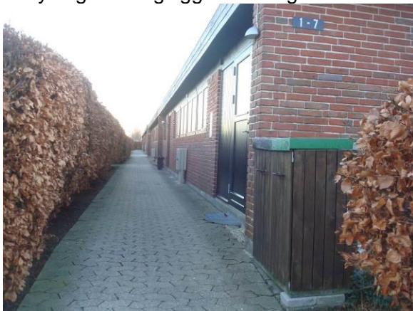
Foto nr. 15 – flisebelægning foran alle ejendomme, matrikelskel direkte i husmur
